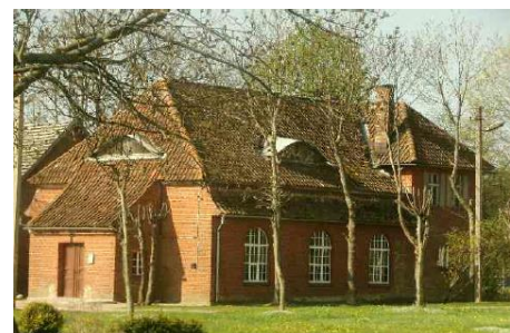
Pav. Nr. 3 Kintų evangelikų liuteronų bažnyčios parapijos namai
