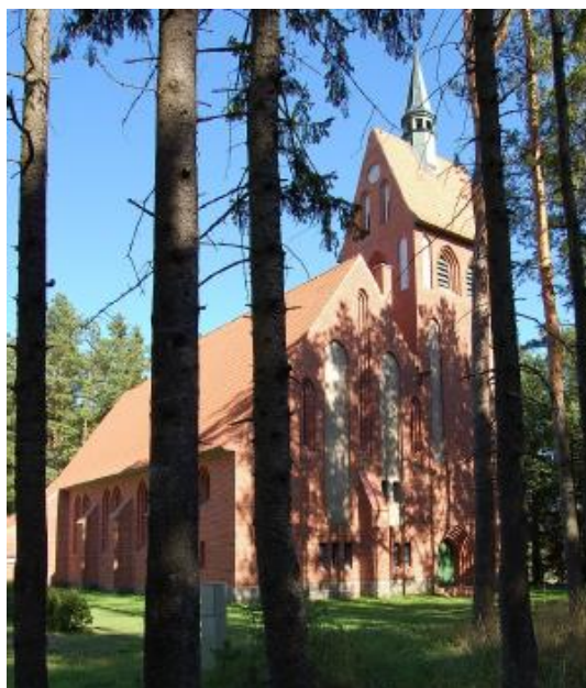
Pav. Nr. 35 Vanagų evangelikų liuteronų bažnyčia
