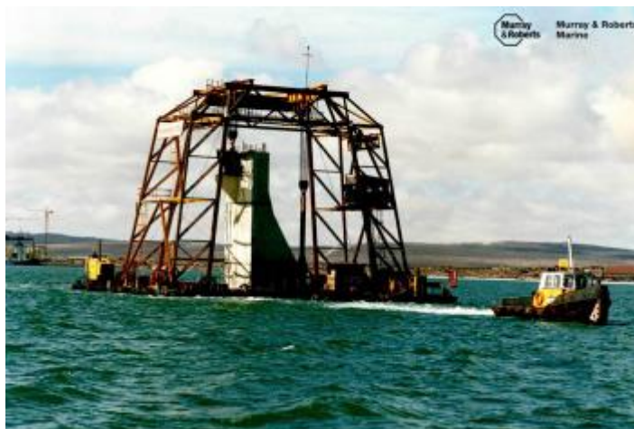
3 pav. Masyvo-giganto nuleidimas į vietą (šaltinis: https://www.sciencedirect.com/topics/engineering/quay-walls )
