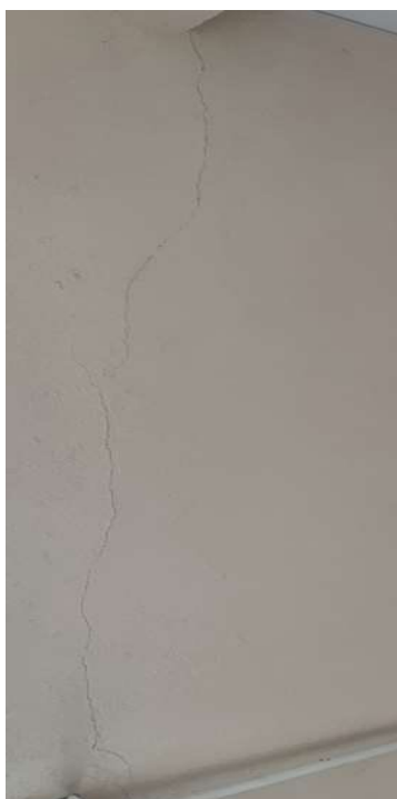
2 pav. Nestruktūrinis defektas
