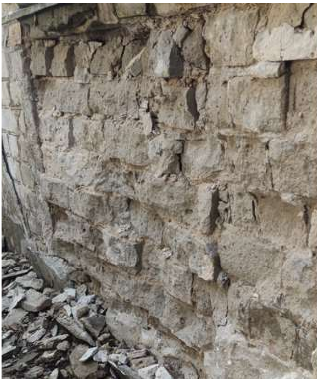
7 pav. Netinkamos kokybės mūriniai elementai
