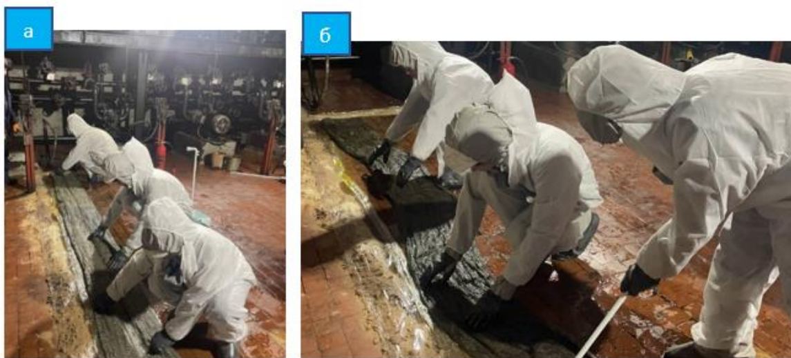
Рис. 1. Барьер, для локализации разлива нефтепродуктов, а) укладка сорбционных полотнищ, б) Съем впитавшего нефтепродукт сорбционного полотнища с места разлива
