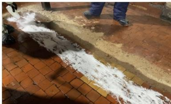
Рис. 3. Нанесения неорганического сорбента для окончательной очистки поверхности
