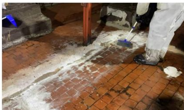
Рис. 4. Удаление неорганического сорбента шанцевым инструментом
