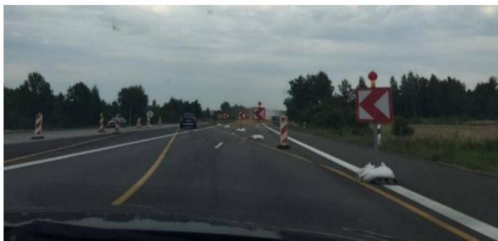
3.10 pav. Ilgalaikis ir trumpalaikis horizontalus ženklinimas A1 kelyje
