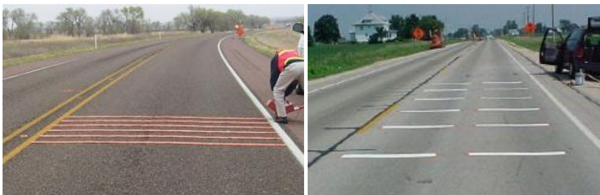
2.38 pav. Laikinos, iš gumos įrengtos, skersinės triukšmo juostos greičio mažinimui (Wang et al. 2011)
