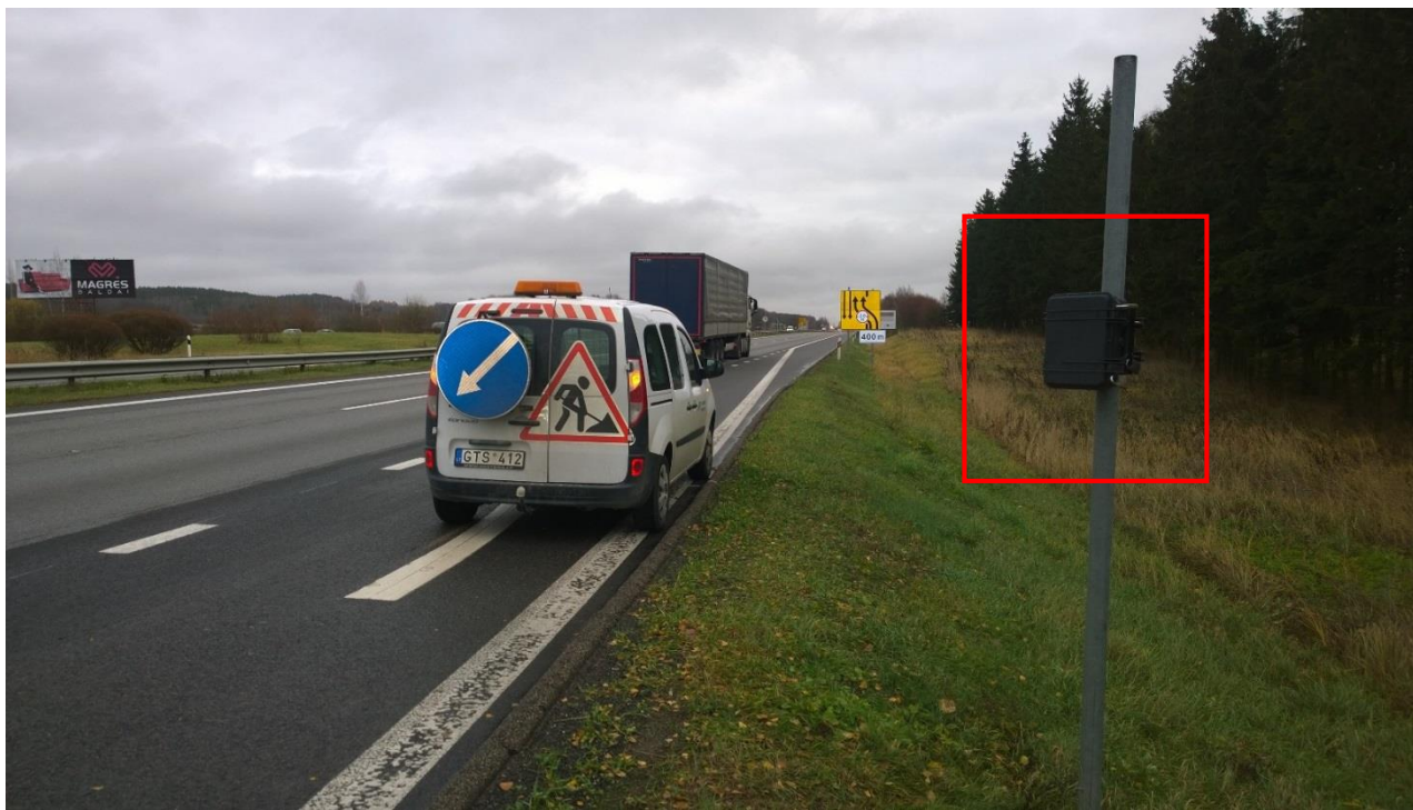
3.3 pav. Transporto priemonių greičio ir klasifikavimo įrenginys
