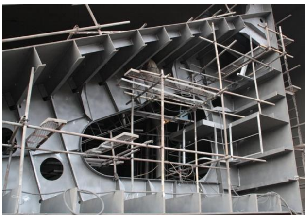
18 pav. Viso konstrukcijų bloko valymas iki Sa 2,5 švarumo [42]
