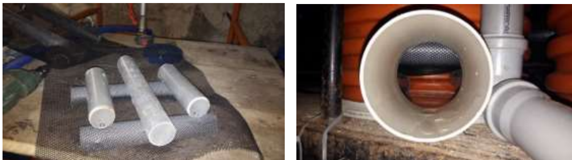
2.4 pav. Užpildą palaikančiojo sluoksnio konstrukcija
