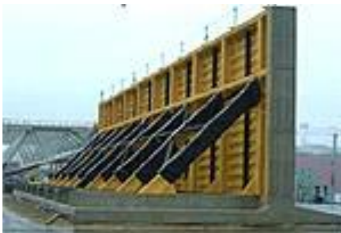
5 pav. Kampinių sienučių krantinės su vidiniu inkaru
