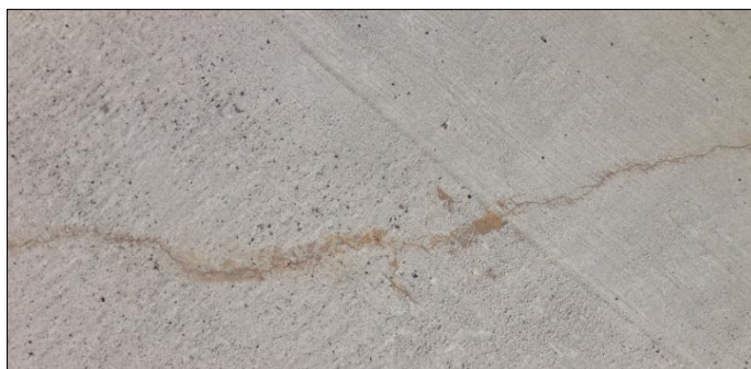
12-13 pav. Sulfatų, rūgščių ir ar kitų komponentų, sukelta betono korozija
