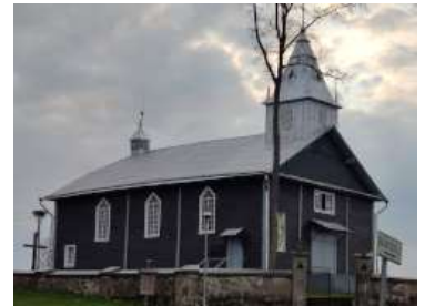
2.48 pav. Beižonių Šv. Kryžiaus Išaukštinimo bažnyčia
