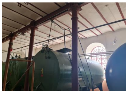
e.6.2 Obelių dvaro sodybos spirito varykla, Rokiškio r., Obelių sen., Obelių m., Stoties g., statyta 1907 m., 22833; kodas registre iki 2005.04.19: G53K1, korpuso fasadas, metalo sijų konstrukcija su lėkštu skliautiniu mūro (plytos) perdenginys, išaukštintos dalies fasadas, nuotraukos Vidos Miškūnaitės-Jarošienės, 2022, p. 48, 64
