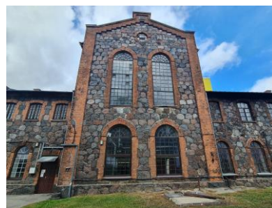
e.6.2 Obelių dvaro sodybos spirito varykla, Rokiškio r., Obelių sen., Obelių m., Stoties g., statyta 1907 m., 22833; kodas registre iki 2005.04.19: G53K1, korpuso fasadas, metalo sijų konstrukcija su lėkštu skliautiniu mūro (plytos) perdenginys, išaukštintos dalies fasadas, nuotraukos Vidos Miškūnaitės-Jarošienės, 2022, p. 48, 64
