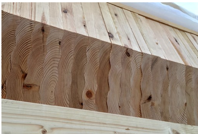
9 pav. Banguotai sluoksniuota mediena – WLT fragmentas (New Nordic Timber, 2019)
