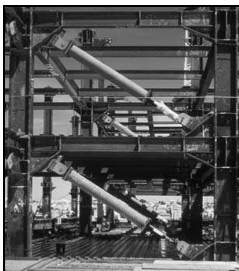
13 pav. Slopintuvai (amortizatoriai) dangoraižyje (Charleson, A. 2008)
