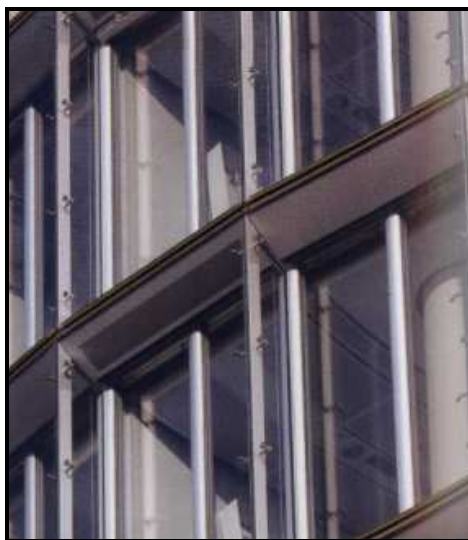
21 pav. „Kvėpuojančio dvigubo fasado“ sistema (Höweler, E. 2003)
