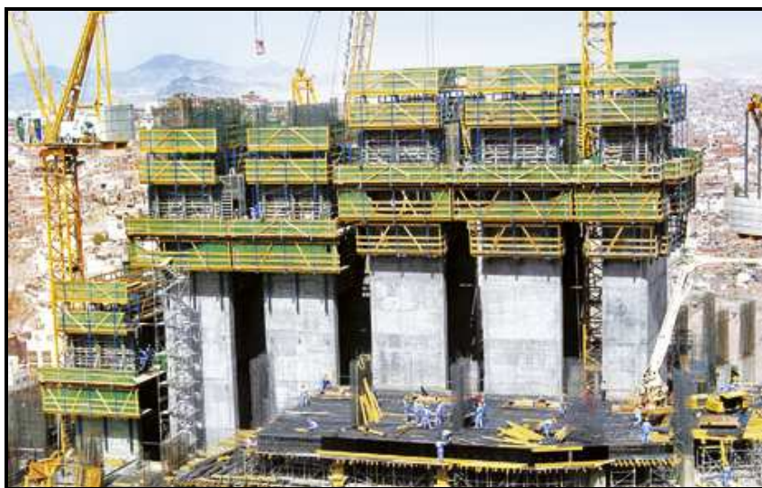
27 pav. „Kylančių klojinių“ panaudojimas statyboje (Doka 2010)
