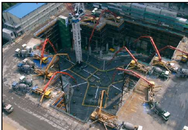
29 pav. „Tower Palace III“ pamato plokštės betonavimas (Abdelrazaq, A. K., et al. 2004)
