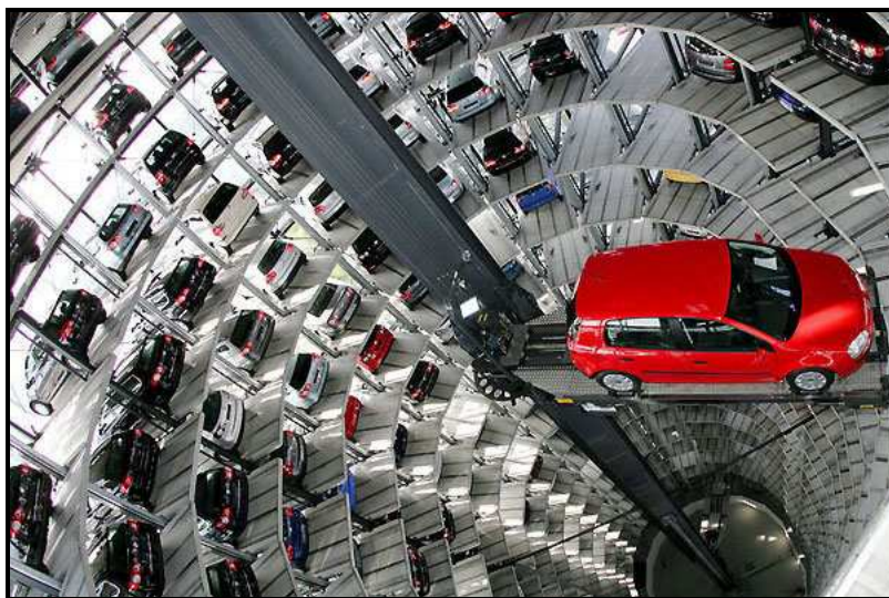
23 pav. Dangoraižio automobilių stovėjimo aikštelė panaudojant keltuvus (McCarthy, M.; Skrebo, E. 2010)
