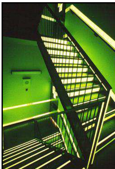
25 pav. Fotoluminescenciniai šviestuvai laiptinėse (Ferreira, M.; Cutonilli, J. 2008)
