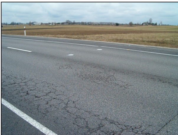
1.8 pav. Naujai įrengto kelio asfaltbetonio dangos pažaidos
