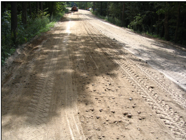
3.13 pav. 5 cm storio sluoksnio įrengimas iš smėlio prieš paklojant geotekstilę
