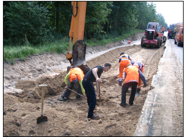
3.5 pav. Apsauginio šalčiui atsparaus sluoksnio medžiagų iškasimas rankiniu būdu
