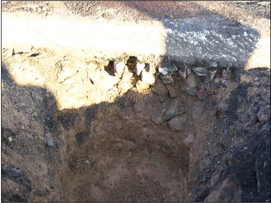
1.7 pav. Vilniaus tarptautinio oro uosto lėktuvų riedėjimo tako dangos sluoksnių medžiagų susimaišymas [18]
