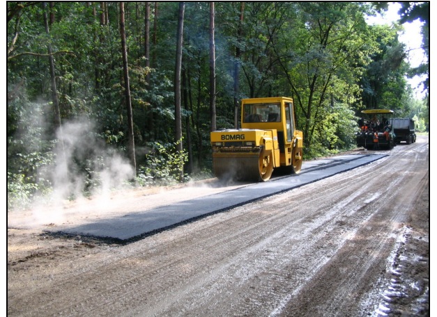
3.15 pav. Asfaltbetonio dangos įrengimas bandymų ruože: a) asfaltbetonio sluoksnio klojimas; b) asfaltbetonio sluoksnio tankinimas
