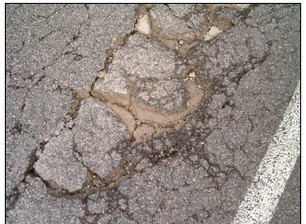
1.8 pav. Naujai įrengto kelio asfaltbetonio dangos pažaidos
