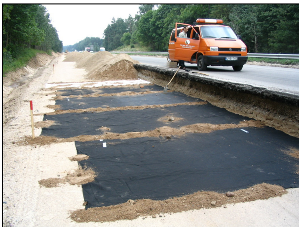
3.2 pav. 5 rūšių geotekstilė paklota ant žemės sankasos
