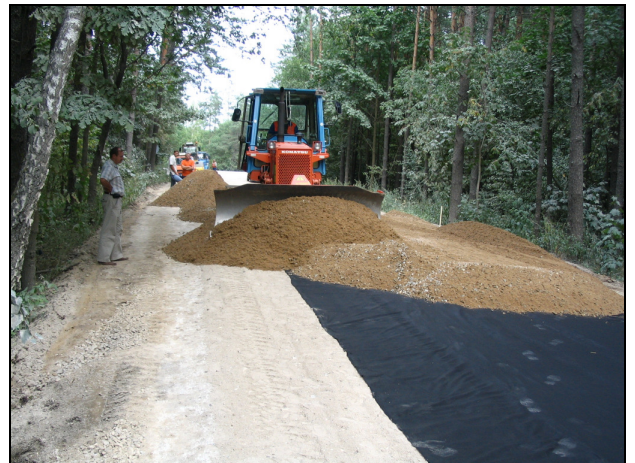
3.14 pav. Dangos pagrindo įrengimas, medžiagas užstumiant buldozeriu
