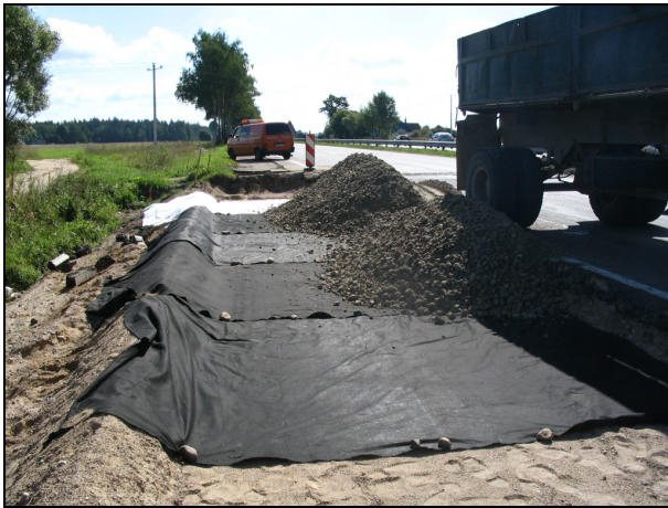
3.4 pav. Penkių rūšių geotekstilės bandinių įrengimas ant apsauginio šalčiui atsparaus sluoksnio
