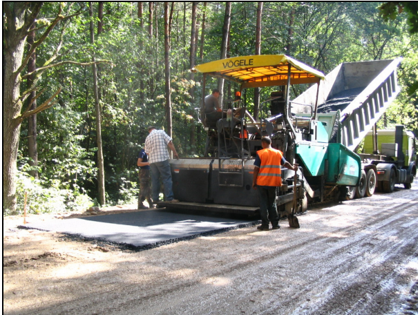
3.15 pav. Asfaltbetonio dangos įrengimas bandymų ruože: a) asfaltbetonio sluoksnio klojimas; b) asfaltbetonio sluoksnio tankinimas
