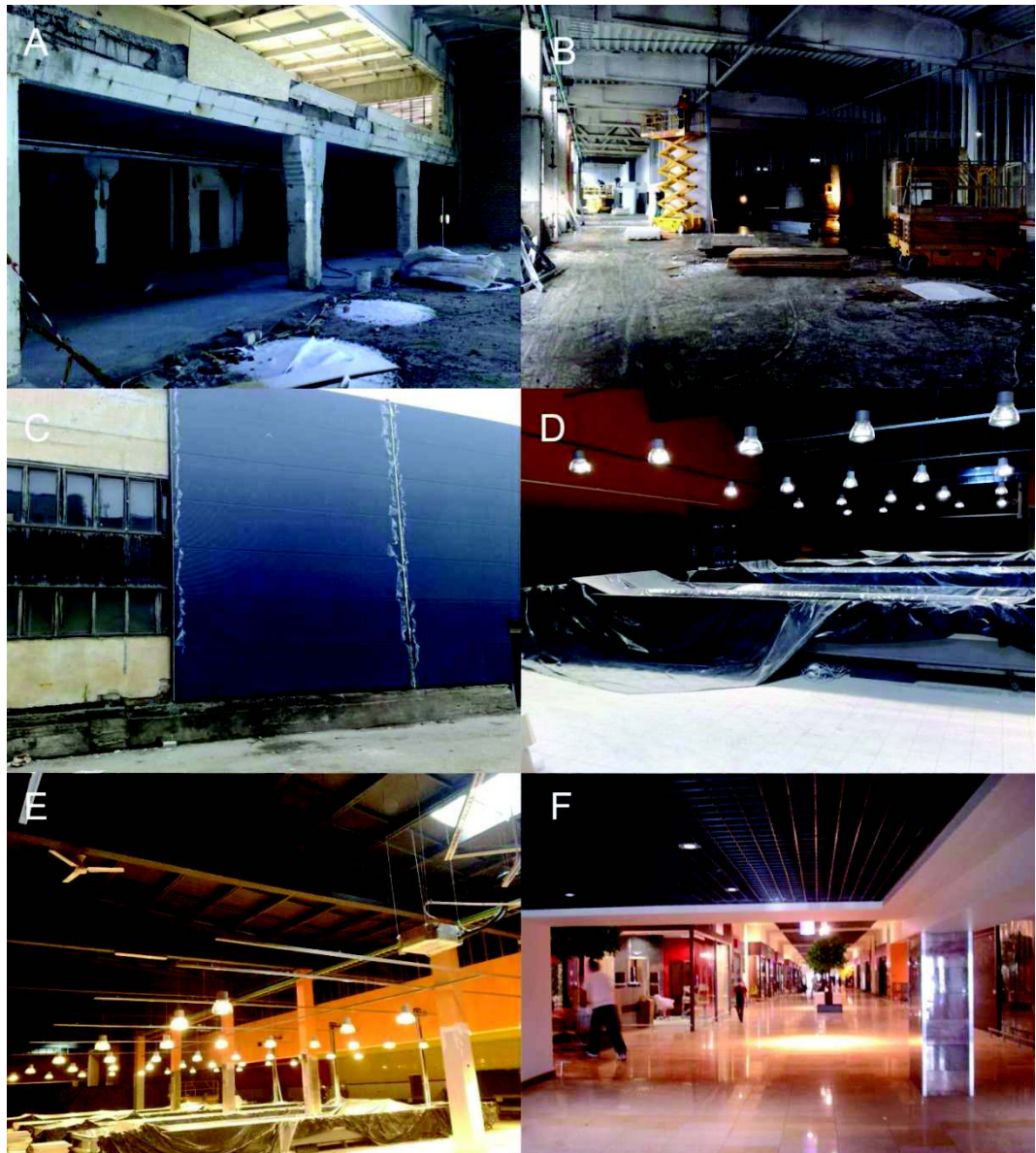
30 pav. Vilniaus Vingio penktojo korpuso rekonstrukcijos darbai (a-e) ir interjeras (f)
