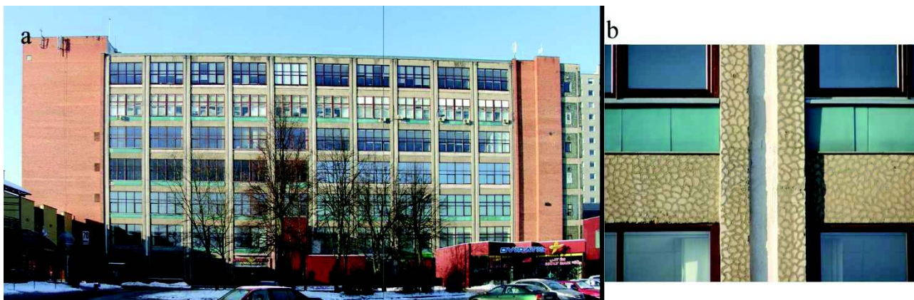
46 pav. Vilmos gamyklos laboratorinio korpuso fasado bendras vaizdas (a) ir fasado detalė (b)
