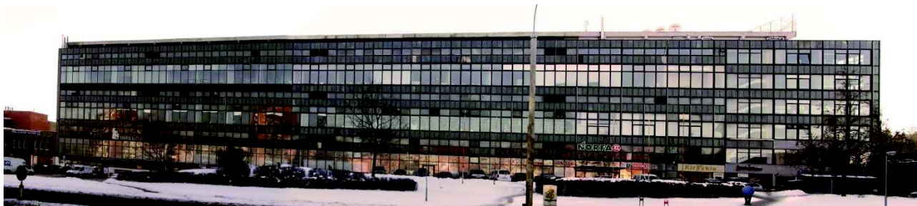
45 pav. Ventos gamyklos Ateities gatvėje daugiaaukščio gamyklinio pastato fasado bendras vaizdas
