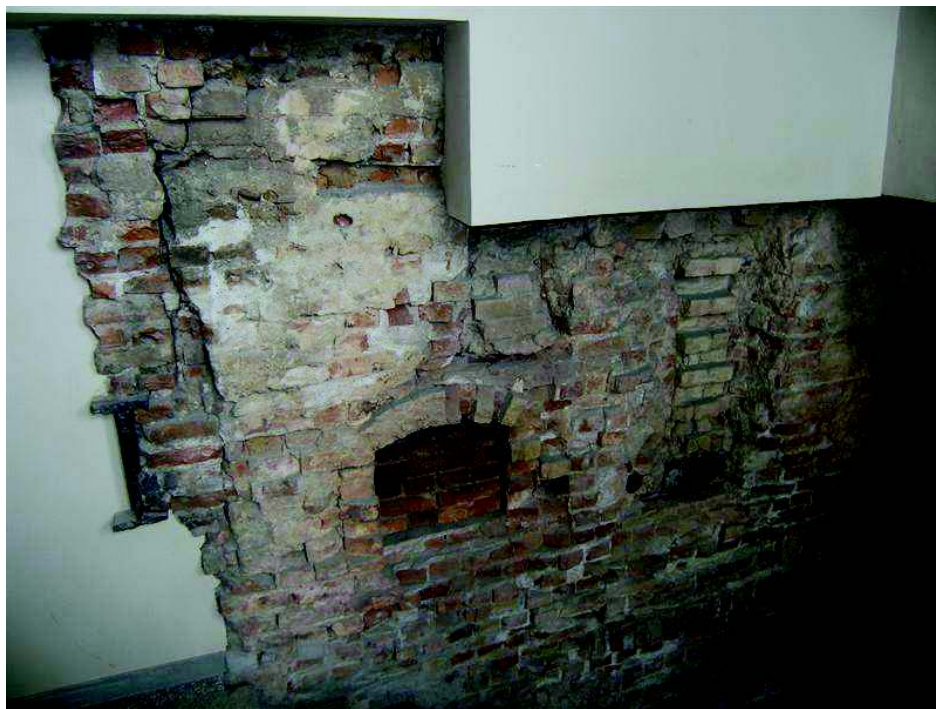
44 pav. Atidengtos pirmojo katilo statybinės konstrukcijos naujai įrengtoje laiptinėje
