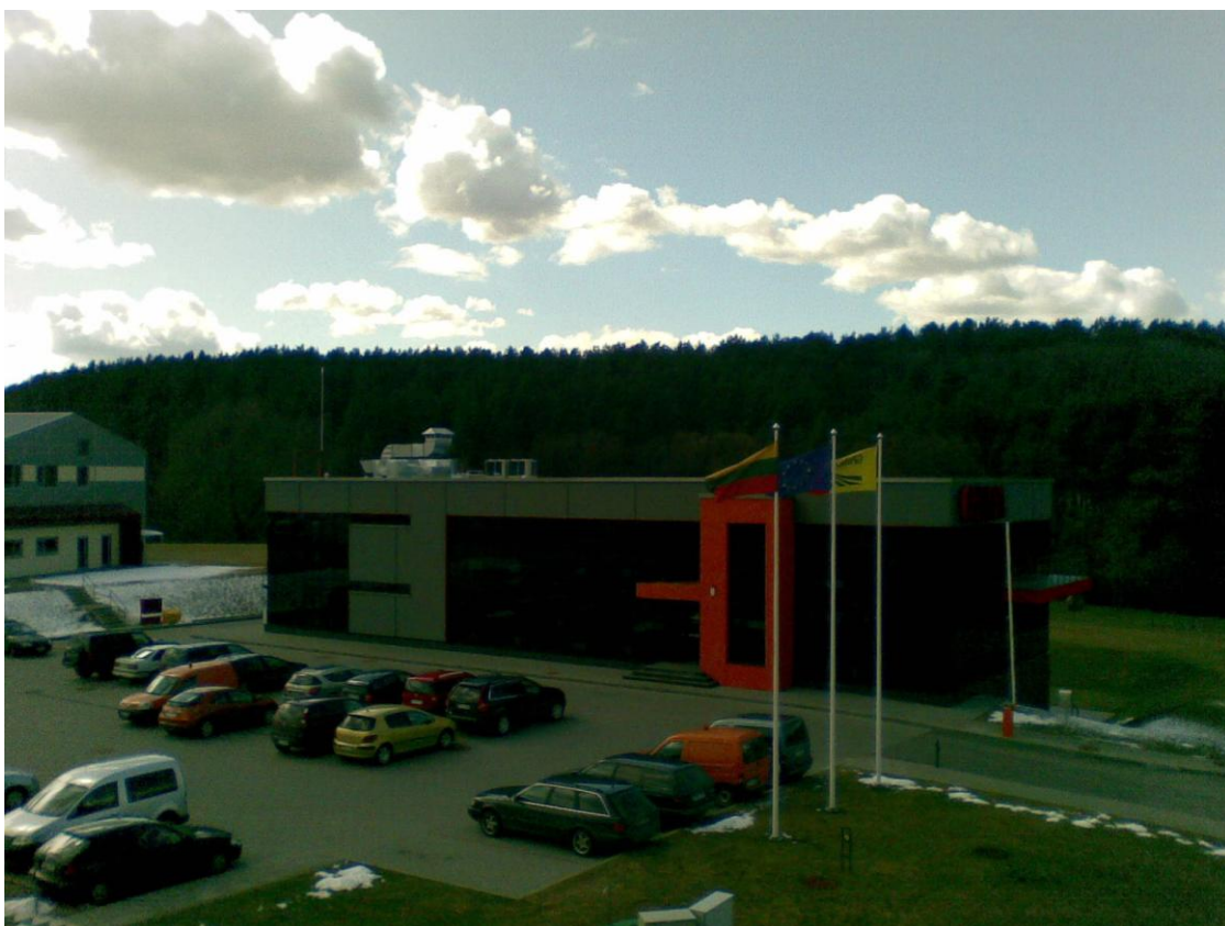
1 pav. UAB „Grinda“ administracinės paskirties pastatas
