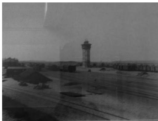
e) Vilniaus geležinkelio vandentiekio bokštas
