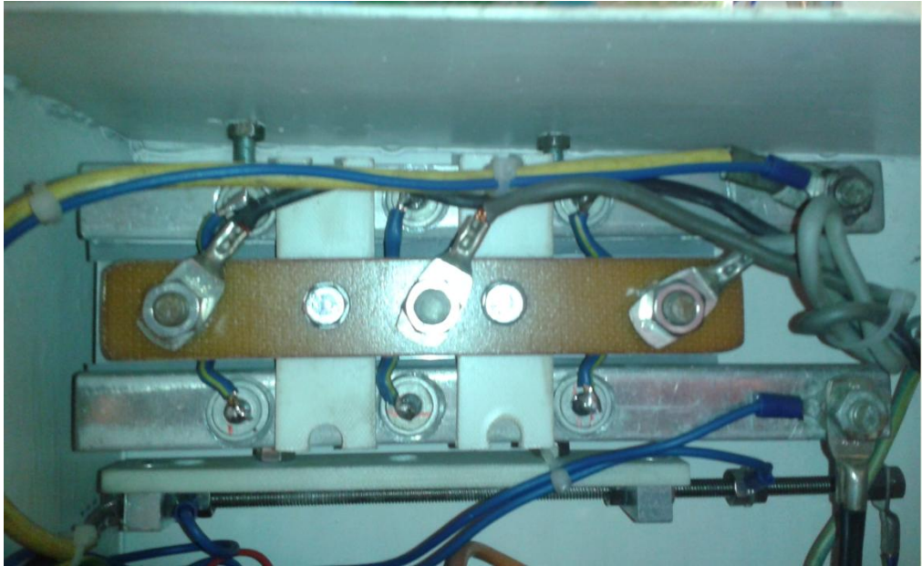
2.23 pav. Trifazis diodinio lygintuvas sumontuotas ant aušintuvo (nuotrauka autoriaus, 2013)
