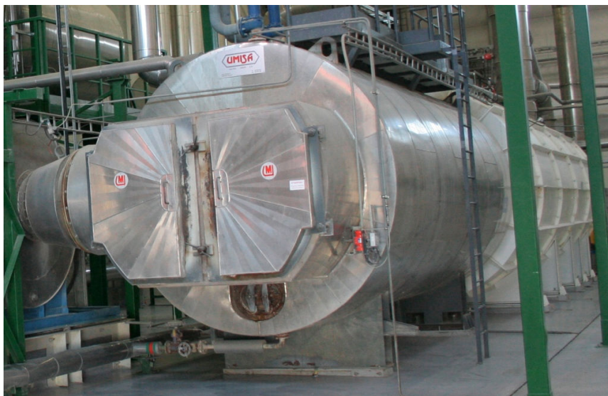
Fig. 2.3 Thermal oxidizing boiler „UMISA -CR/11,9 (13) “
