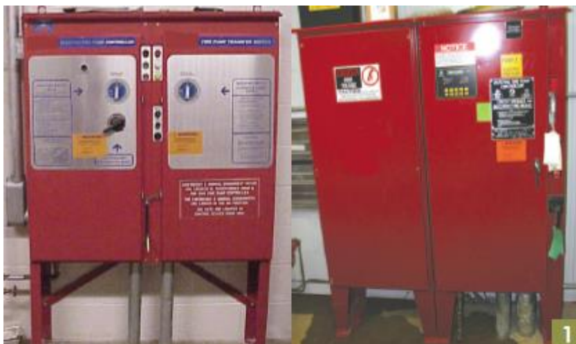
Pav. 2.2.1 Tipinė priešgaisrinės siurblinės stotis
