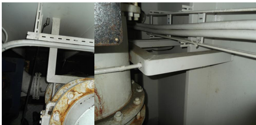
2.2.20 pav. Tiriamo siurblio Nr.2 slėgimo vamzdžio tvirtinimas
