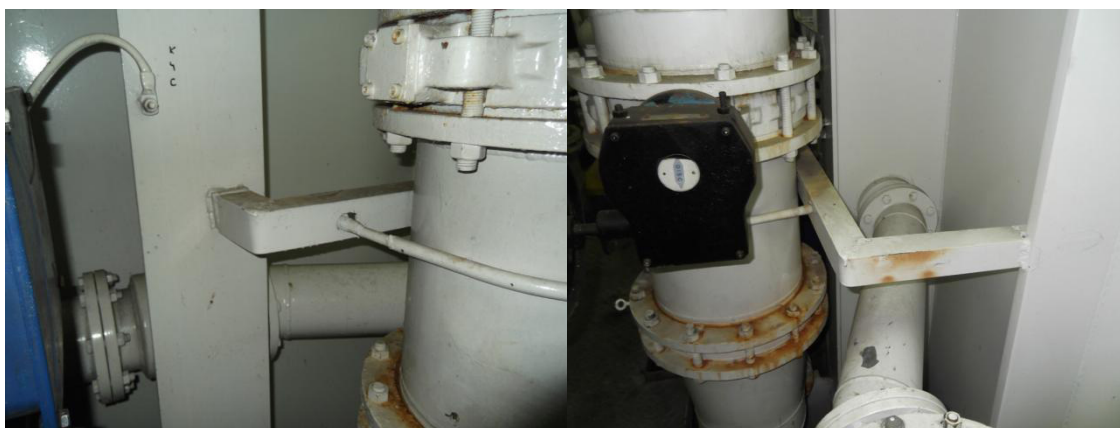
2.2.21 pav. Reguliariai eksploatuojamo siurblio Nr.1 slėgimo vamzdžio tvirtinimas
