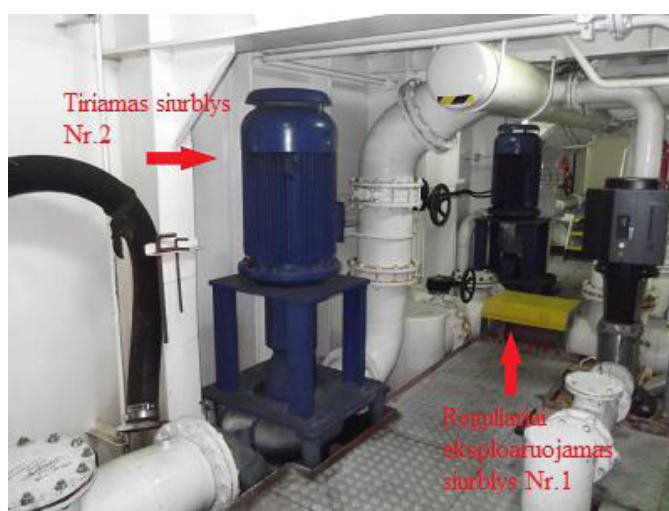
2.1.3 pav. Kelto „Seaways Optima“ pagrindinių variklių gėlo vandens kontūro aušinimo siurbliu
