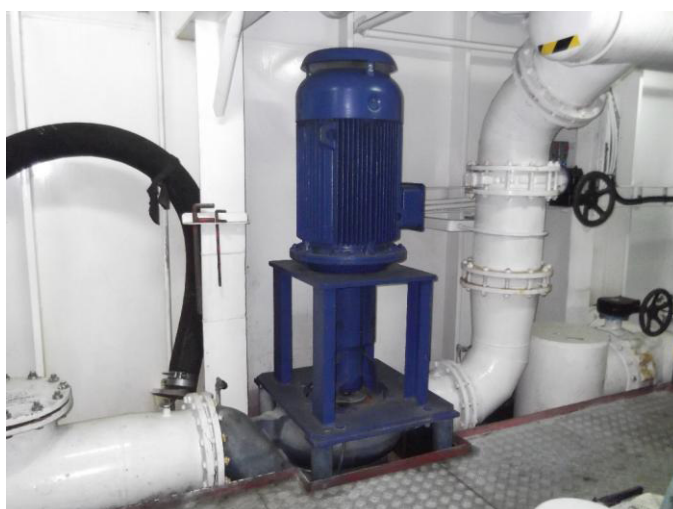
2.1.2 pav. Kelto „Seaways Optima“ pagrindinių variklių gėlo vandens kontūro aušinimo siurblys Nr. 2 (tyrimo objektas)
