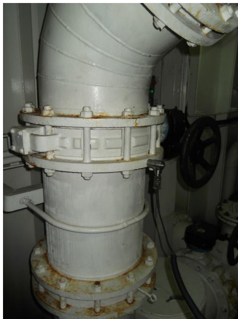
2.2.11 pav. Virpesių matavimo jutiklio padėtis „vamzd 1“ „Bump“ testo metu
