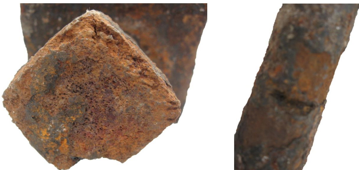
43 pav. Inkarinio varžto korozija
