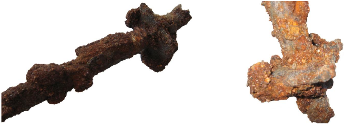
37 pav. Korozijos produktai inkarinio varžto apatinėje dalyje
