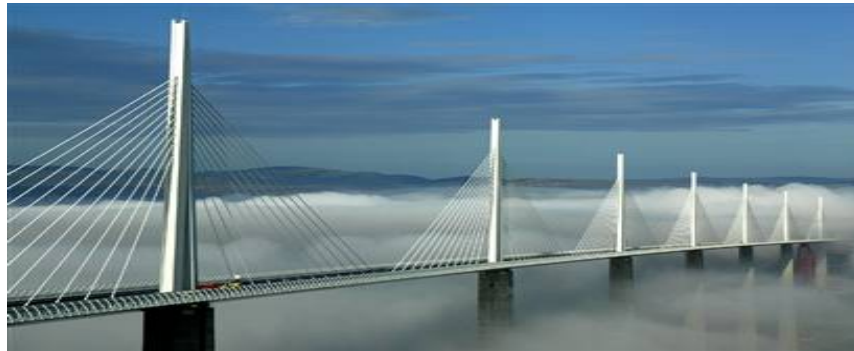
1.9 pav. Millau viadukas (Prancūzija) [29]
