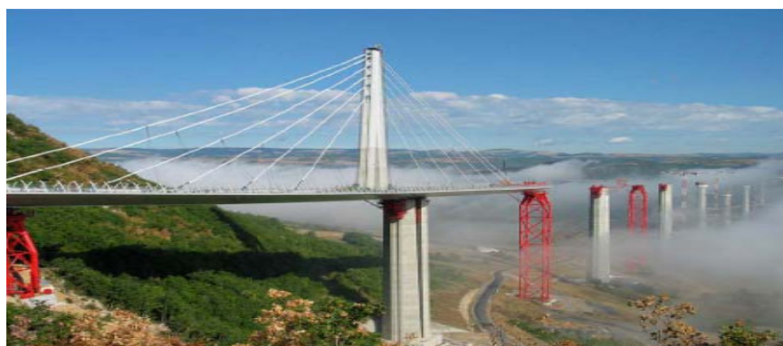
1.10 pav. Transportuojamas Millau tilto segmentas [22]
