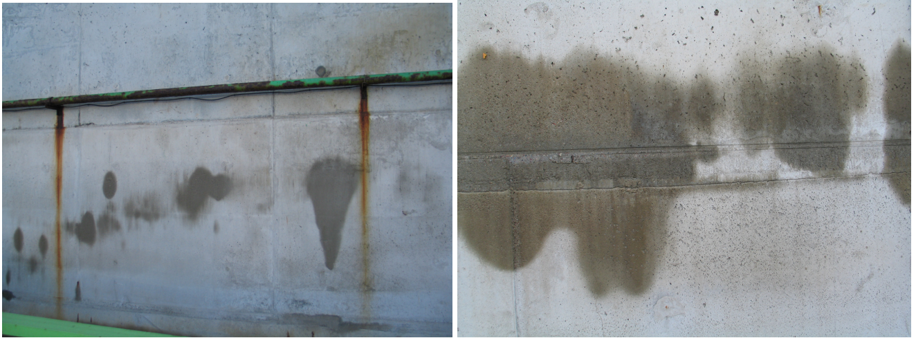
5 pav. Karbamido difuzija į išorinę sandėlio pusę
