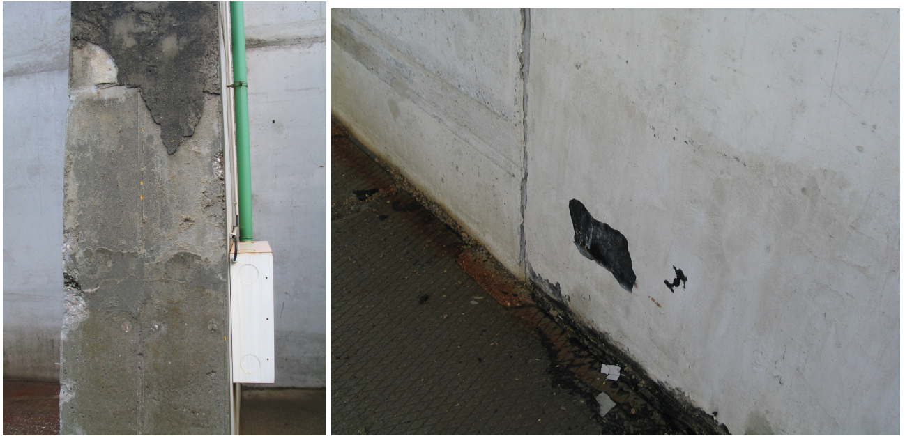
2 pav. Nutrupėję skiedinio ir tinko sluoksniai
