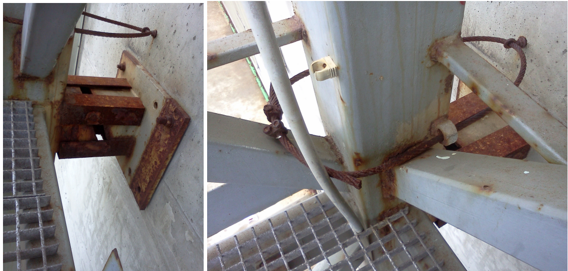
34 pav. Paslanki atrama jungianti sieną ir laiptinės kolonas
