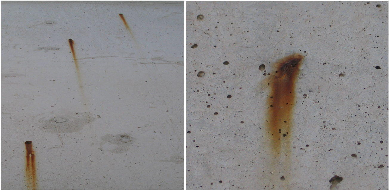
4 pav. Piritu nuspalvintas betono paviršius
