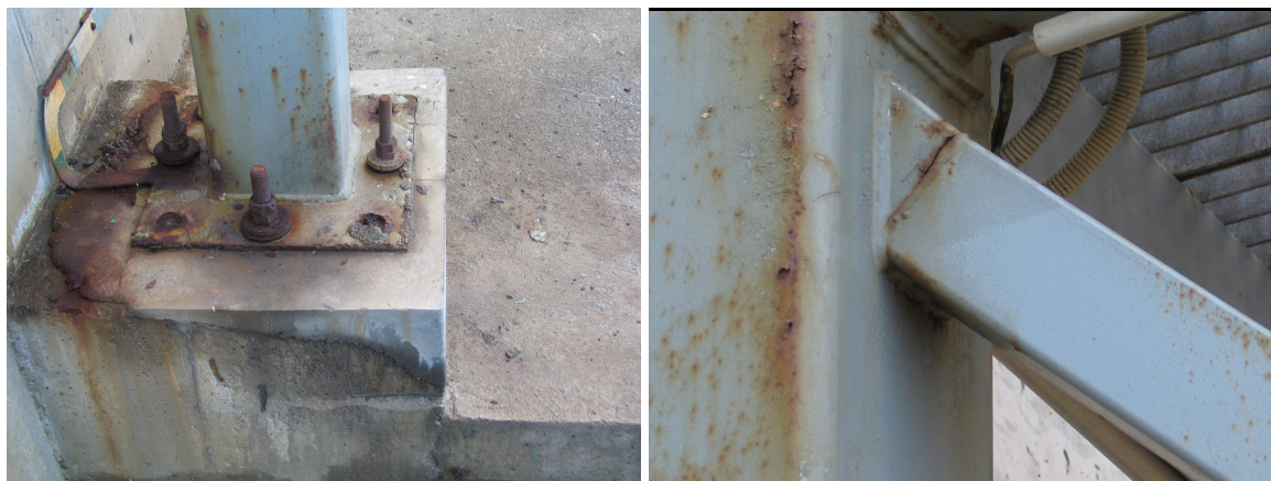
33 pav. Sandėlio sienos poslinkio padariniai
