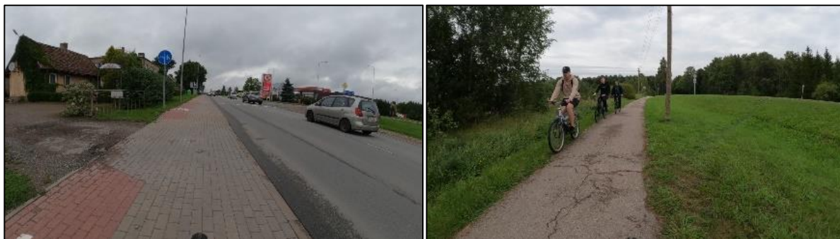
3.33 pav. Dviračių trasos dangos plotis per siauras saugiai prasilenkti eismo dalyviams
