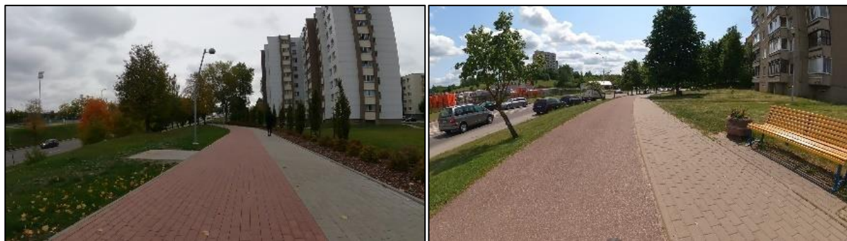
3.39 pav. Neatskirti priešpriešiniai dviračių srautai
