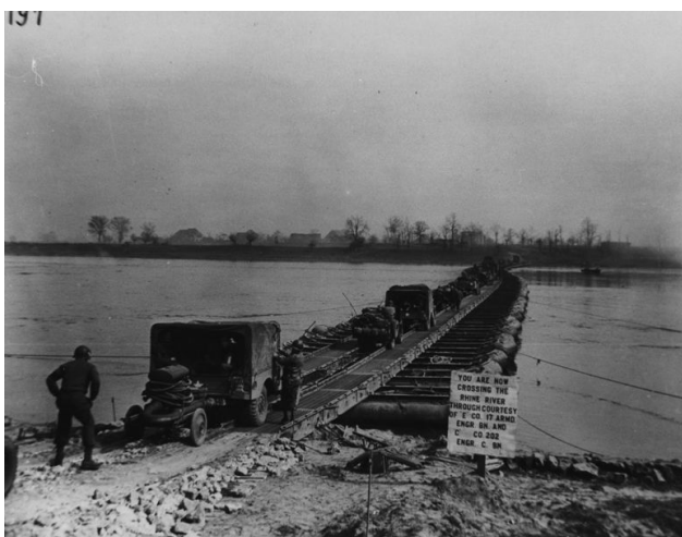
6 pav. JAV kariuomenės laikinu plieniniu pontoniniu tiltu keliai per Reino upę. Tiltą laiko įvairūs daiktai: valtys, statinės, plastiko plūdės (1945 m. nuotrauka)
