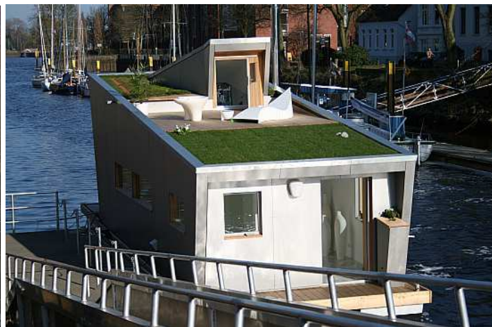
25 pav. Plūduriuojantis namas Oldenberge
