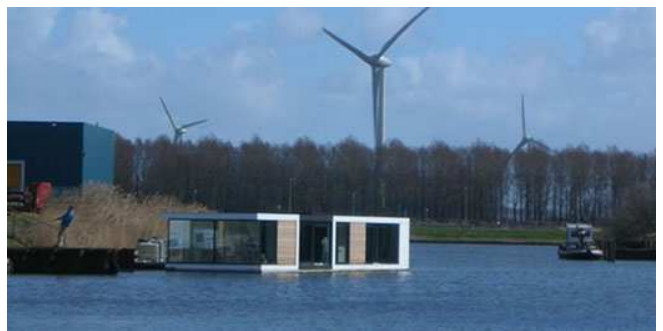
29 pav. „Watervilla” tipinis namas ant vandens
