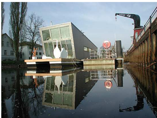
24 pav.. Plūduriuojantis namas Oldenberge
