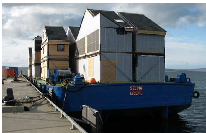
50 - 51 pav. Modulinų gamyklinių pastatų transportavimas vandeniu
