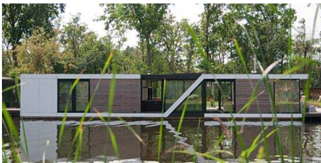
28 pav. „Watervilla” tipinis namas ant vandens.
