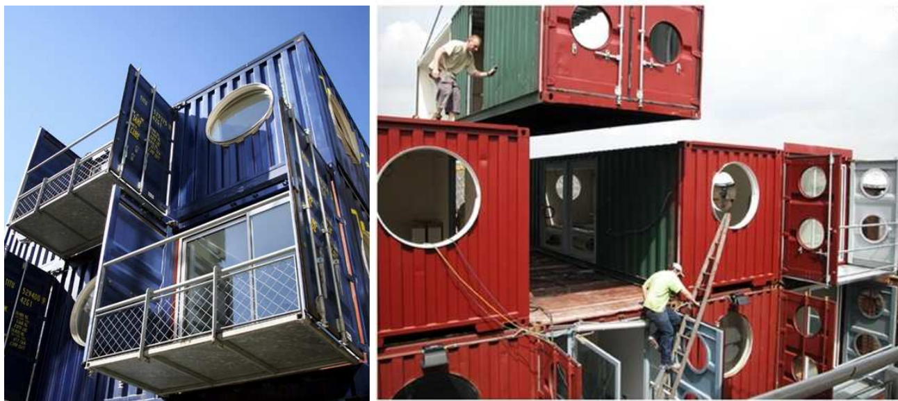
62 - 63 pav. „Container City“ kompleksas. Architektai: N. Lacey Architects & Eric Reynolds/ Buschow Henley/ ABK Architects. 2001 m. Londonas, Jungtinė Karalystė
