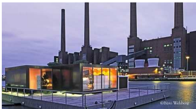
34 pav. Plūduriuojanti sporto salė ir spa Wolfsburg
