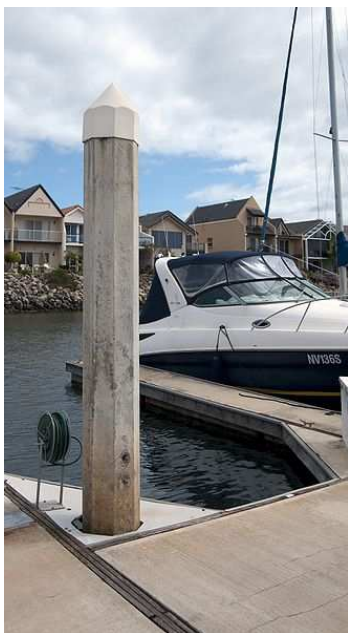
9 pav. Pontonų tvirtinimas prie krantinės poliais
