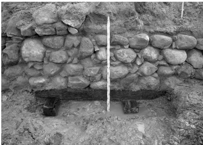
15 pav. Rostverkas po bažnyčios pamatais. G. Zabielos nuotr. (Zabiela, 2007)
