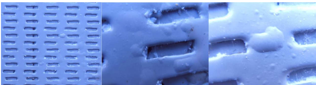
44 pav. Epoksidinio gruntu „EOPRIM“ dangos atšokimai
