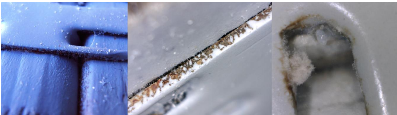
43 pav. Plieno korozija ties briaunomis ir dygiais bandinyje, apsaugotame „EOPRIM“
