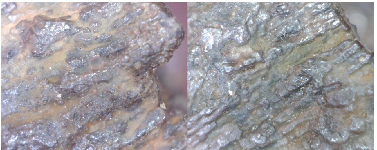
57 pav. Pirmojo kilio strypo išorinės dalies korozija
