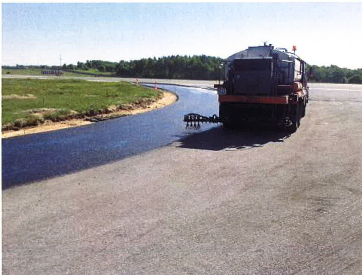
1.7 pav. Bituminės emulsijos užpurškimo ant kelio dangos technologinis procesas
