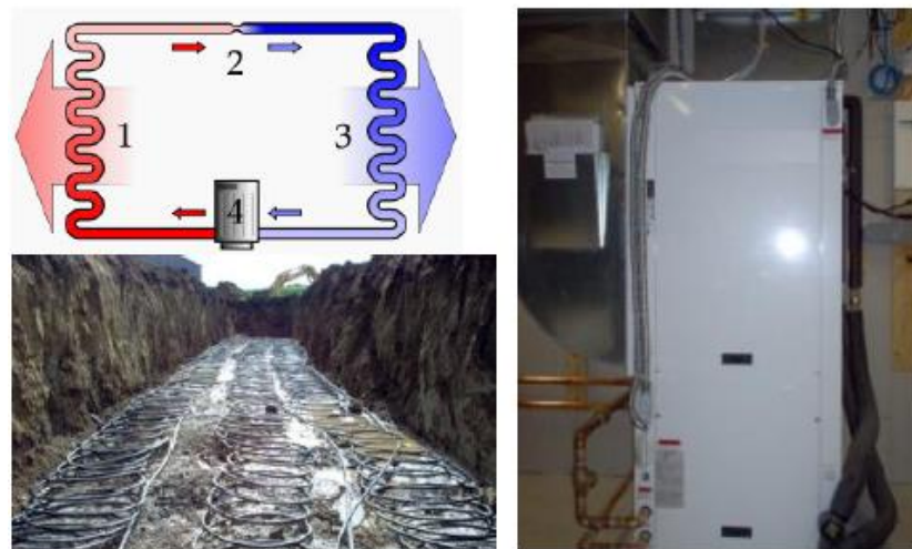
3 pav. Horizontalaus kolektoriaus išvedžiojimas grunte
