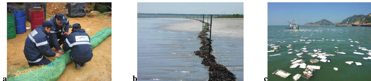
8 pav. Sorbentų panaudojimas išsiliejusios naftos ir jos produktų surinkimui:
