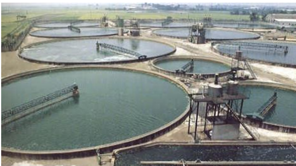
1 pav. Radialinis atvirojo tipo reaktorius (Lee, 2001)
