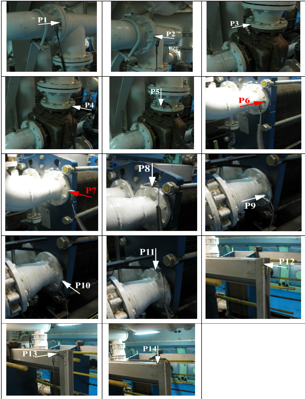
2.2.3 pav. Matavimo taškai ant šilumokaičio ir jo vamzdyno PORT pusė
