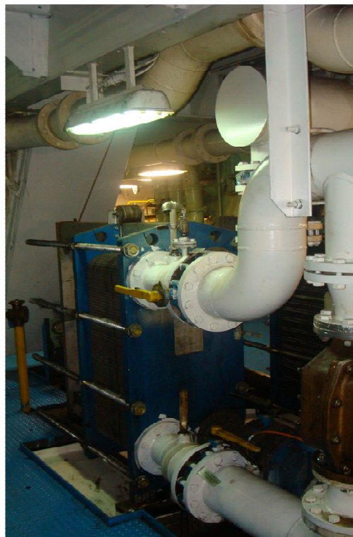
2.3.1 pav. Šilumokaičio vamzdynas ir jo tvirtinimas
