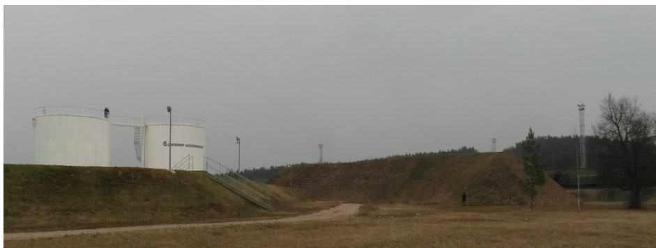
S10 pav. Grunto pylimas (dešinėje), pastatytas apsaugoti degalų saugyklą (kairėje) nuo geležinkelio cisternos sprogimo BLEVE būdu (autorės nuotrauka)
