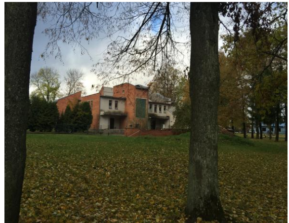
17 il. Rekonstrukcinis parduotuvės pastatas. 2015
