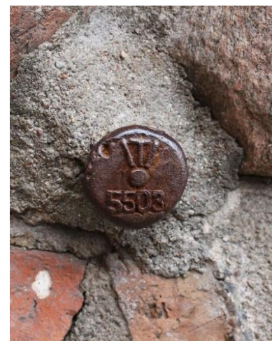
9 pav. Sieninis reperis (UAB „Inžineriniai tyrinėjimai <...>“ 2007 (kairėje); fotografuota autoriaus 2016 (dešinėje))
