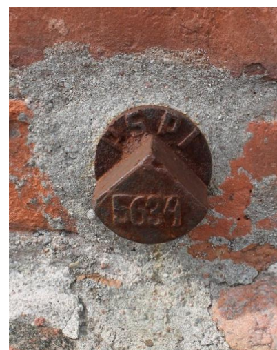
10 pav. I tipo sieninis reperis (UAB „Inžineriniai tyrinėjimai <...>“ 2007 (kairėje); fotografuota autoriaus 2016 (dešinėje))
