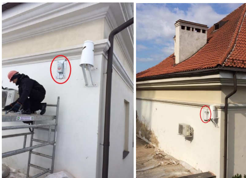
27 pav. Kairėje – GEOSENSE sistemos montavimas (Abromavičius 2017); dešinėje – įmontuotas komutatorius (fotografuota autoriaus 2017)
