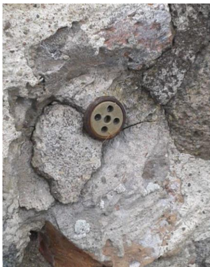
14 pav. Pietinio bokšto pamatuose esanti nebeatsisukanti sėdimo markė Nr. 8 (fotografuota autoriaus 2016)
