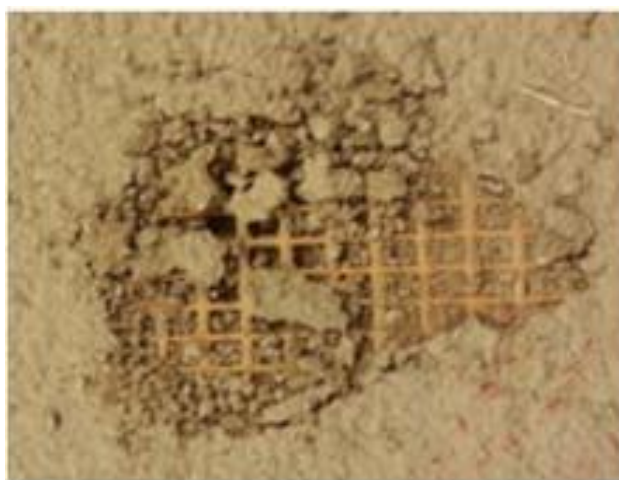
18 pav. Pažeidimo rūšis a) armavimo tinklelis matomas ir b) armavimo tinklelis matomas
