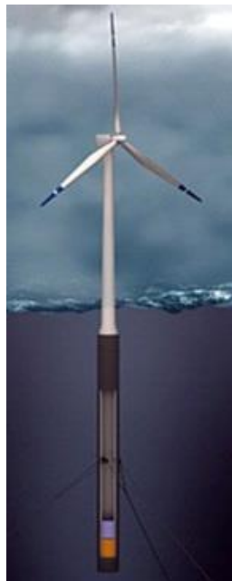
16 pav. Hywind koncepcija (Muliawan et al., 2013)
