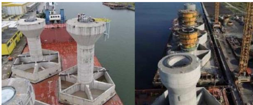
9 pav. Gravitacinio tipo pamatai, kurie buvo naudojami Šiaurės jūroje pastatytai vėjo jėgainei (Esteban et al., 2015)
