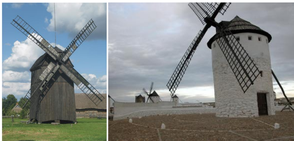
2 pav. Stiebinis vėjo malūnas Lenkijoje ir kepurinis vėjo malūnas Ispanijoje (Igliński et al., 2016; Rojas-Sola et al., 2016)
