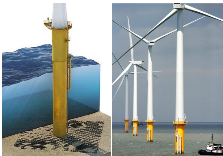
11 pav. 2007 metų pabaigoje buvo pastatytas 25 vėjo jėginių parkas monopoliniais pamatais Liverpulyje, Velse (Carswell et al., 2016)
