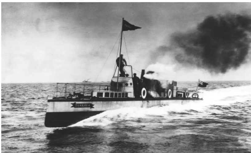
1.5 pav. 1896 metais pastatytas pirmasis laivas su garo turbinos eigos varikliais Turbinia
