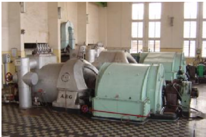
1.25 pav. AEG firmos garų turbinos elektros generatoriai AP-3.8 ir AP-7, pastatyti 1934 ir 1939 metais (2004 metų nuotrauka)
