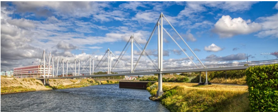
Fig. 1.6. Passerelle du Grand Large (Janberg, 2022)
