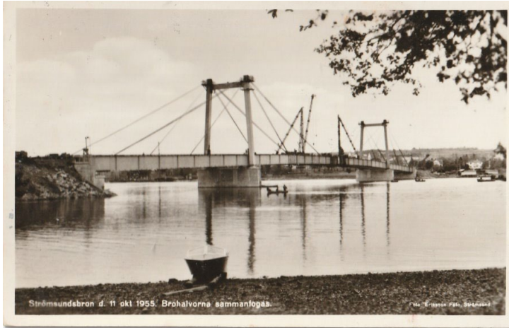
Fig. 1.3. Stromsund Bridge (Eriksson, 1955)
