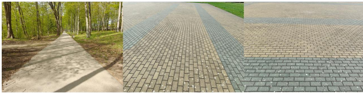
20 pav. Tiriamosios kelio dangos: a) asfaltuotas takas, b) trinkelės sudėtos išilgai, c) trinkelės sudėtos skersai
