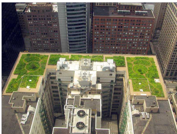
3 pav. Miesto pastatų stogai Čikagoje
