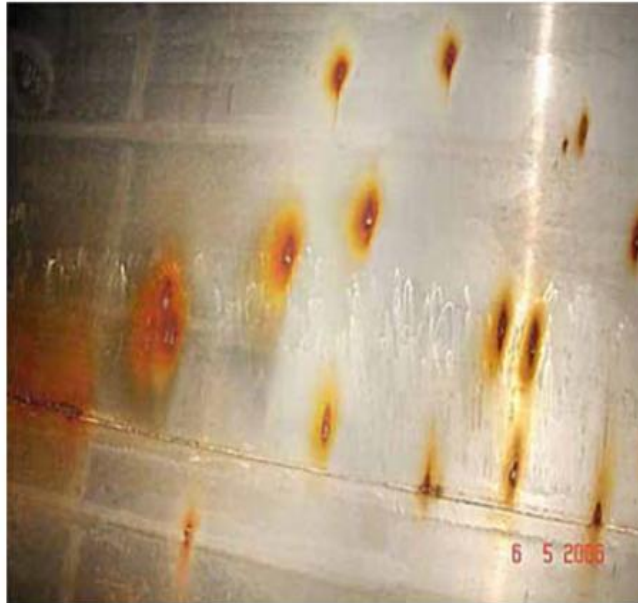
6 pav. Vietinė korozija balastiniame tanke [1]
