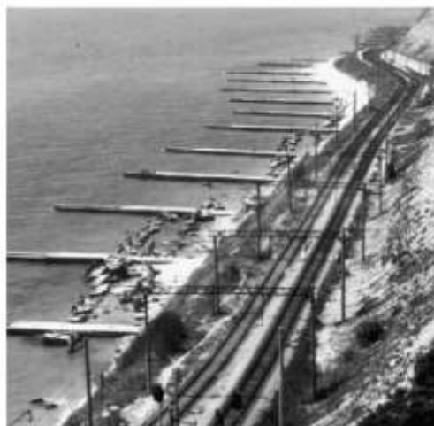
1 pav. Bunos pastatytos Rusijos teritorijoje prie Juodosios jūros ties Tuapsė-Adler geležinkelio linija (Kos'yan et al., 2012)
