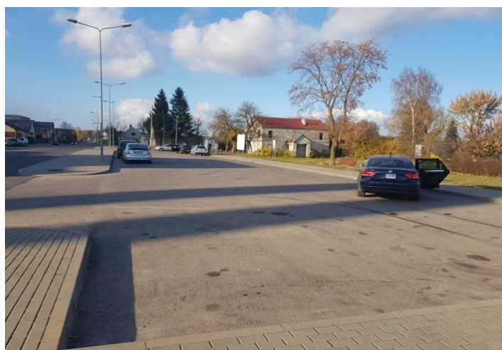
A.24 pav. Krašto kelio Nr. 127 10,34 km aikštelė (fotografuota autoriaus, 2018)
