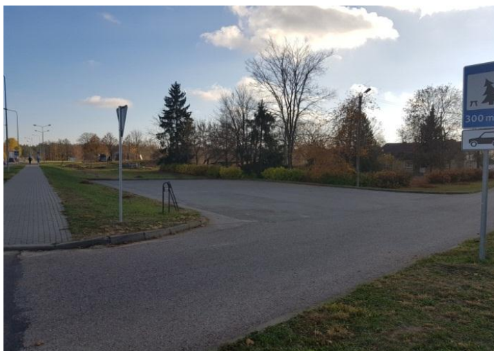
A.25 pav. Krašto kelio Nr. 127 10,411 km aikštelė (fotografuota autoriaus, 2018)
