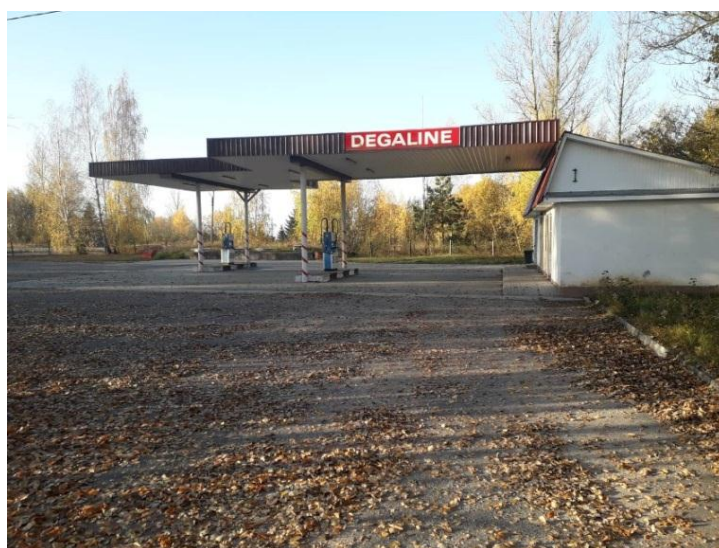
A.27 pav. Krašto kelio Nr. 127 46,004 km aikštelė (fotografuota autoriaus, 2018)
