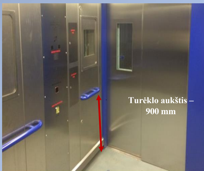
10, 11 pav. Įstaigoje neįgaliesiems pritaikytas liftas (Aut. nuotraukos)
