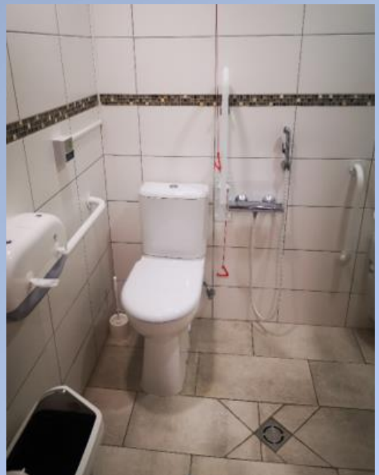
15, 16 pav. San. Mazgo pritaikymas neįgaliesiems. (aut. nuotrauka)
