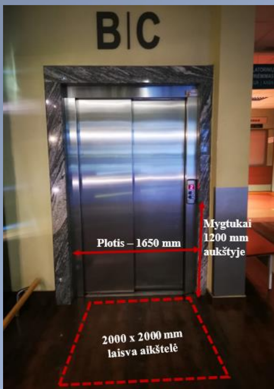
10, 11 pav. Įstaigoje neįgaliesiems pritaikytas liftas (Aut. nuotraukos)
