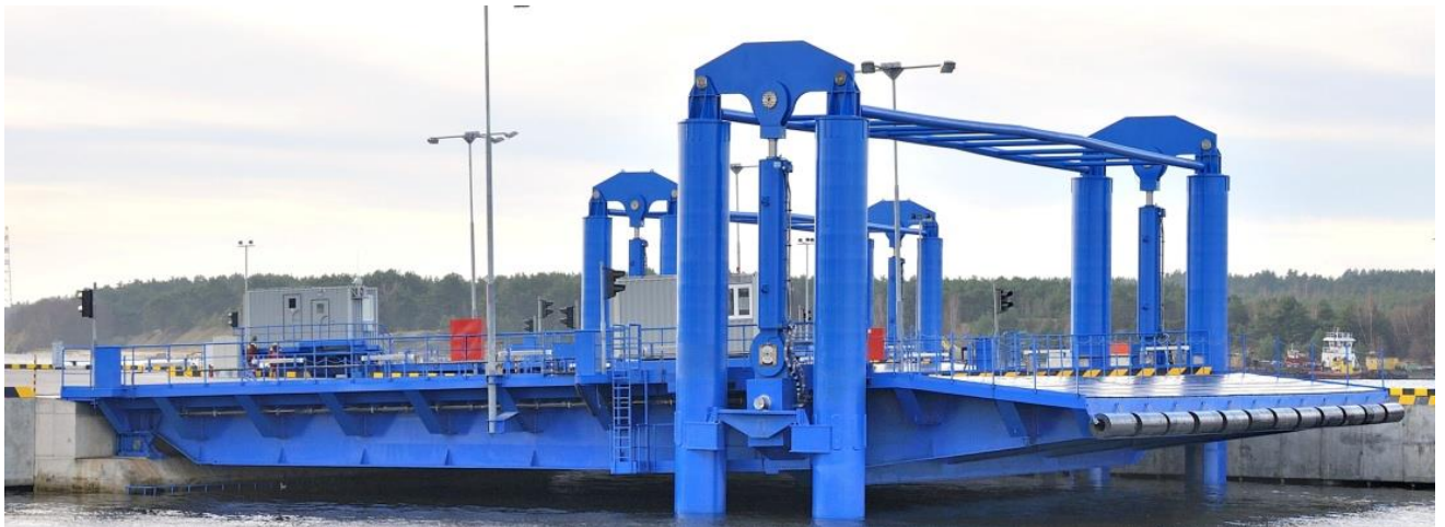
4 pav. 80a krantinės hidraulinė rampa. 6
