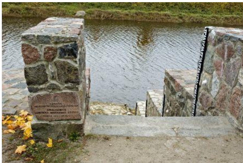
22. Pav. Smalininkų vandens matavimo stotis
