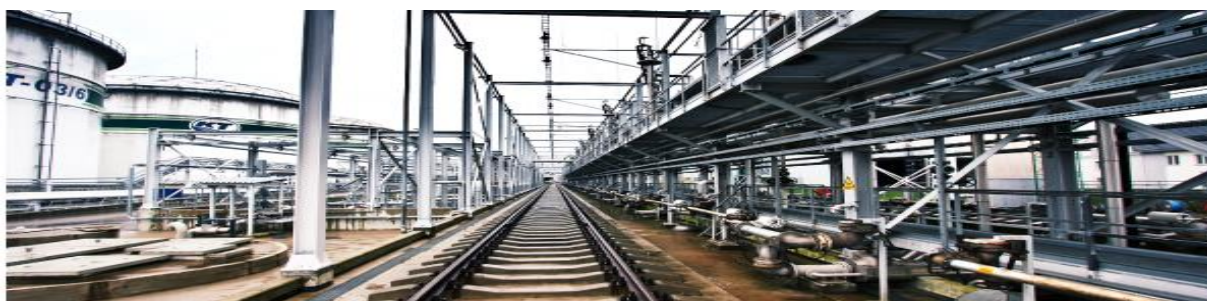
6 pav. Geležinkelio cisternų pakrovimo – iškrovimo estakada 9 .
