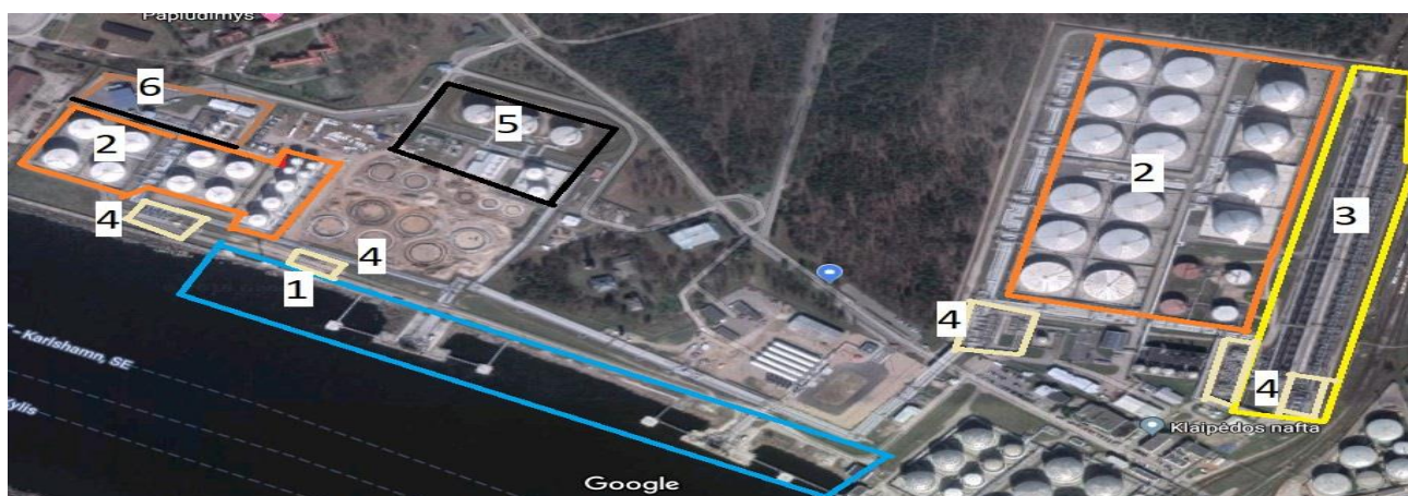
4 pav. AB „Klaipėdos nafta“ naftos terminalo vaizdas.
