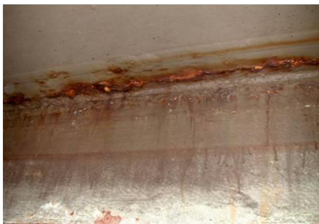
27 pav. Suvirinimo siūlės ir terminio poveikio zonos korozija [3]
