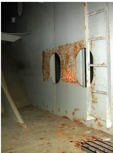
30 pav. Dangos irimas dėl prasto paviršiaus paruošimo [4]
